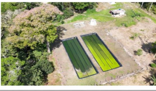
Estação de Tratamento de Águas Marrons
